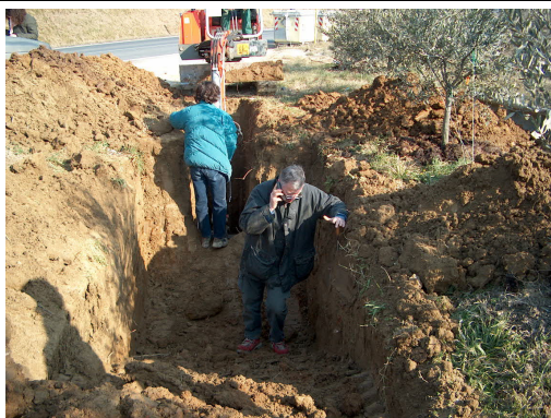
Esecuzione del pozzetto n°1, ubicato sulla sinistra (direzione Firenze) del muro da consolidare.
